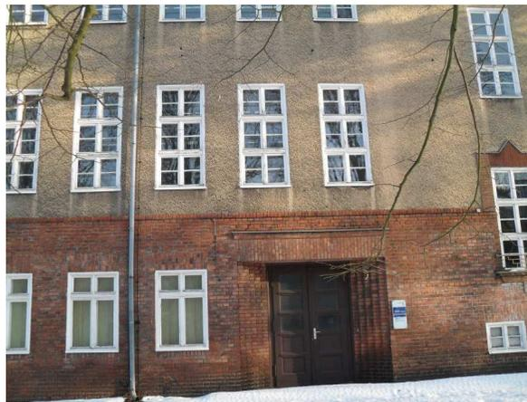
Die Fenster auf den 3 verklinkerten Seiten werden denkmalgerecht aufgearbeitet bzw. am Südgiebel durch neue Holzfenster mit Wärmeschutzverglasung ersetzt. Diese sind mit der Denkmalbehörde abzustimmen. Komplett aufgearbeitet werden die Eingangstüren. Auf der Hofseite sollen neue Holz-Isolierglasfenster eingebaut werden.
