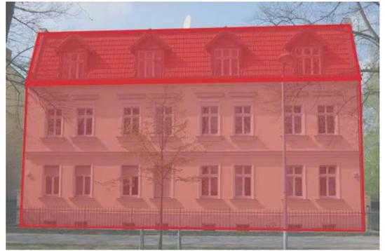
Steiles Dachband und liegende Fassade als prägende Merkmale des Berliner Dachtyps
